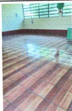
Foto 3: Sustitución de piso de cemento liquido por piso cerámico en aulas, módulo de aulas
