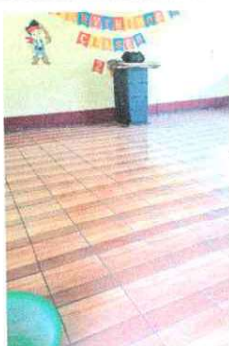
Foto 5: Sustitución de piso de cemento liquido por piso cerámico en aulas, módulo de aulas
