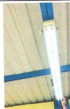
Foto 6: Sustitución de Lámparas Led. Módulo de aulas
